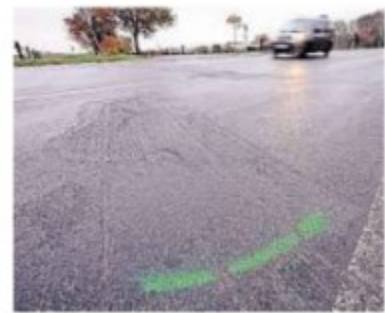
Der Veener Weg in Xanten wurde repariert.
